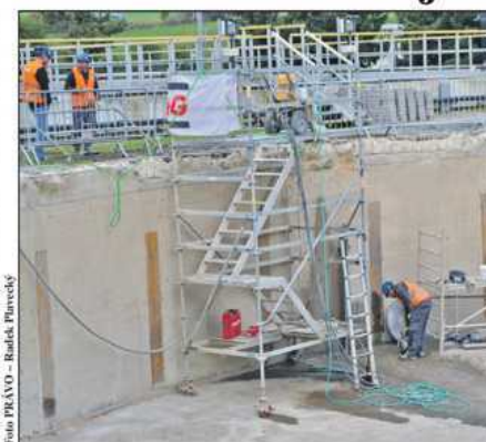
Práce na opravách nádrže na čištění vody v čistírně odpadních vod ve Vrapicích na okraji Kladna.
